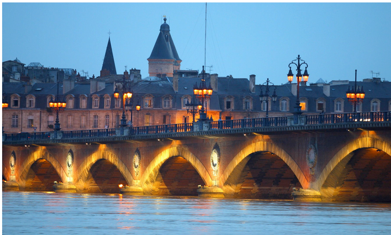
Bordeaux – Le pont de pierre
